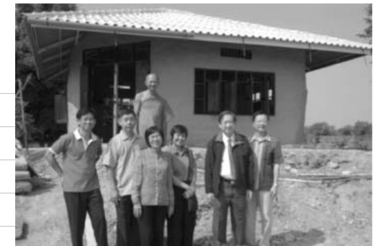
■ บ้านดินตัวอย่าง แนวคิดสร้างหอพักผู้ป่วยที่สกลนคร
