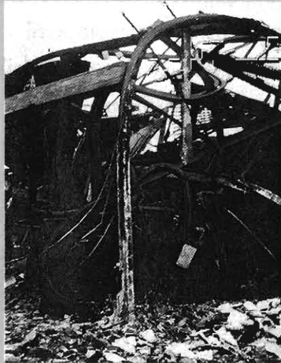
บริษัท เคเดอร์ อินดัสเทรียล (ไทยแลนด์) จำกัด หลังเกิด เหตุการณ์ไฟไหม้และ ด้พังถล่ม ลงมา
