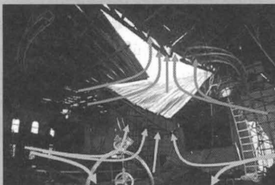
รูปภาพที่ 10 แผ่นหลังคาพังและได้แยกออก ทำให้ก๊าซพิษ คาร์บอนไฟ และความร้อนได้ถูกระบายออกจากอาคาร
