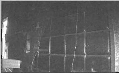
รูปภาพที่ 6 ห้องวีไอพี มินิมัฟองน้ำบุผนังที่ทำจากโพลียูรีเทนโฟม ที่มีโพรงอากาศสามารถลุกลามได้ง่าย
