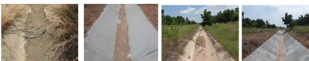
เปรียบเทียบก่อน-หลังการซ่อมแซมคลองชลประทานด้วยมอร์ต้าและวัสดุเคลือบผิวคลอง
